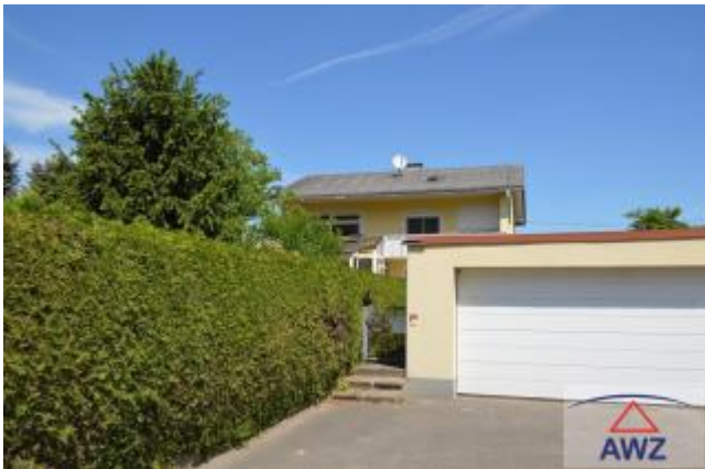
Vorderansicht und Doppelgarage
